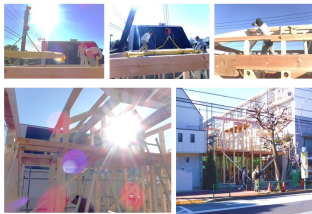
建設進む大井7丁目共同住宅（仮称）
