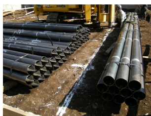
鋼管杭（1本当たり）：長さ約6m 重さ約90Kg
