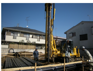
鋼管杭工事：地盤補強のための工事です。（堅い地盤まで杭を打ち込みます）
