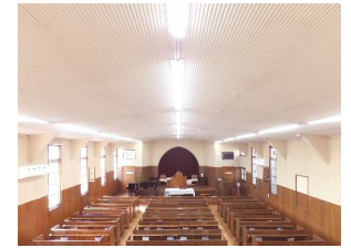
尾山台ナザレン教会 LED化工事
