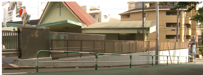
板山台サザン給排水設備壁及びフェンス改築工事
