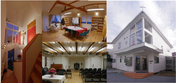
〔施工〕富士土地株式会社 建築事業部 + 〔設計〕ペトラ建築設計 一級建築士事務所
