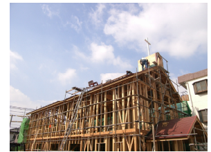
現在施工中の日本同霊基教団青葉キリスト教会
