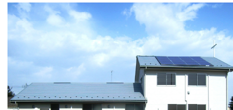
太陽光発電システム事例：横田キリストの教会<年間予測発電電量約2506kwh>
