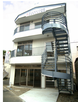
日本聖契キリスト教団中原キリスト教会 竣工
